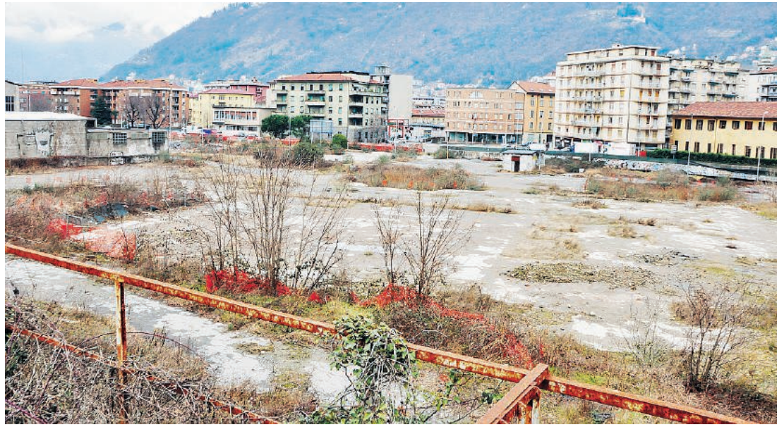
L'area su cui sorgeva la Ticosa non è stata ancora completamente bonificata: il costo finale dell'operazione salirà a 11 milioni di euro (Nassa)
